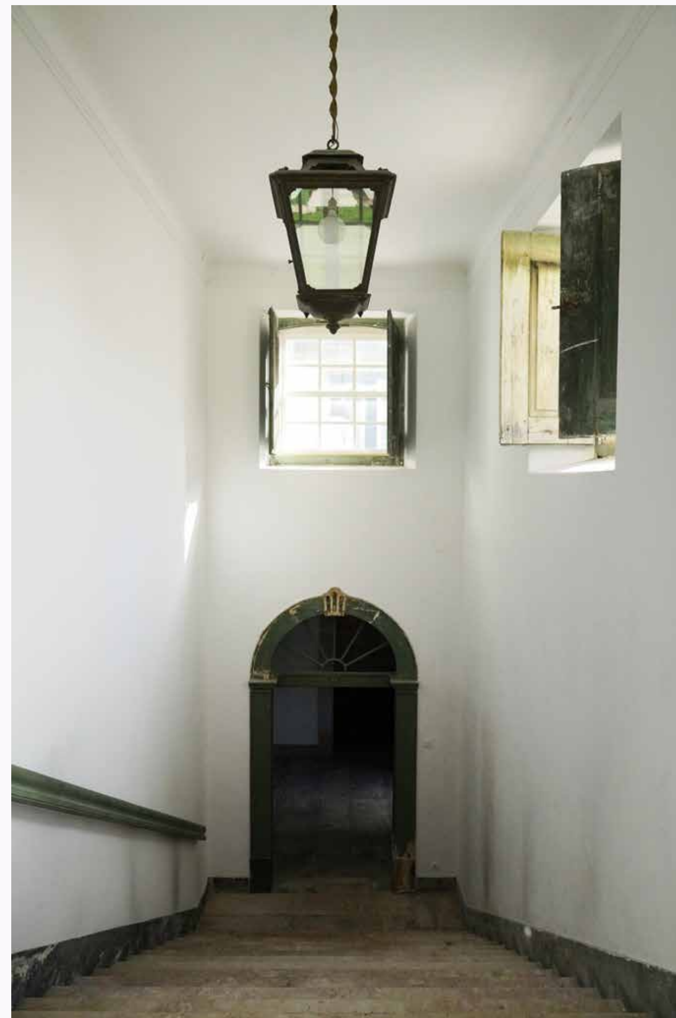
Primeiro lanço da Escada que dá acesso ao andar nobre amplamente iluminado por luz natural e lanterna ao centro.
