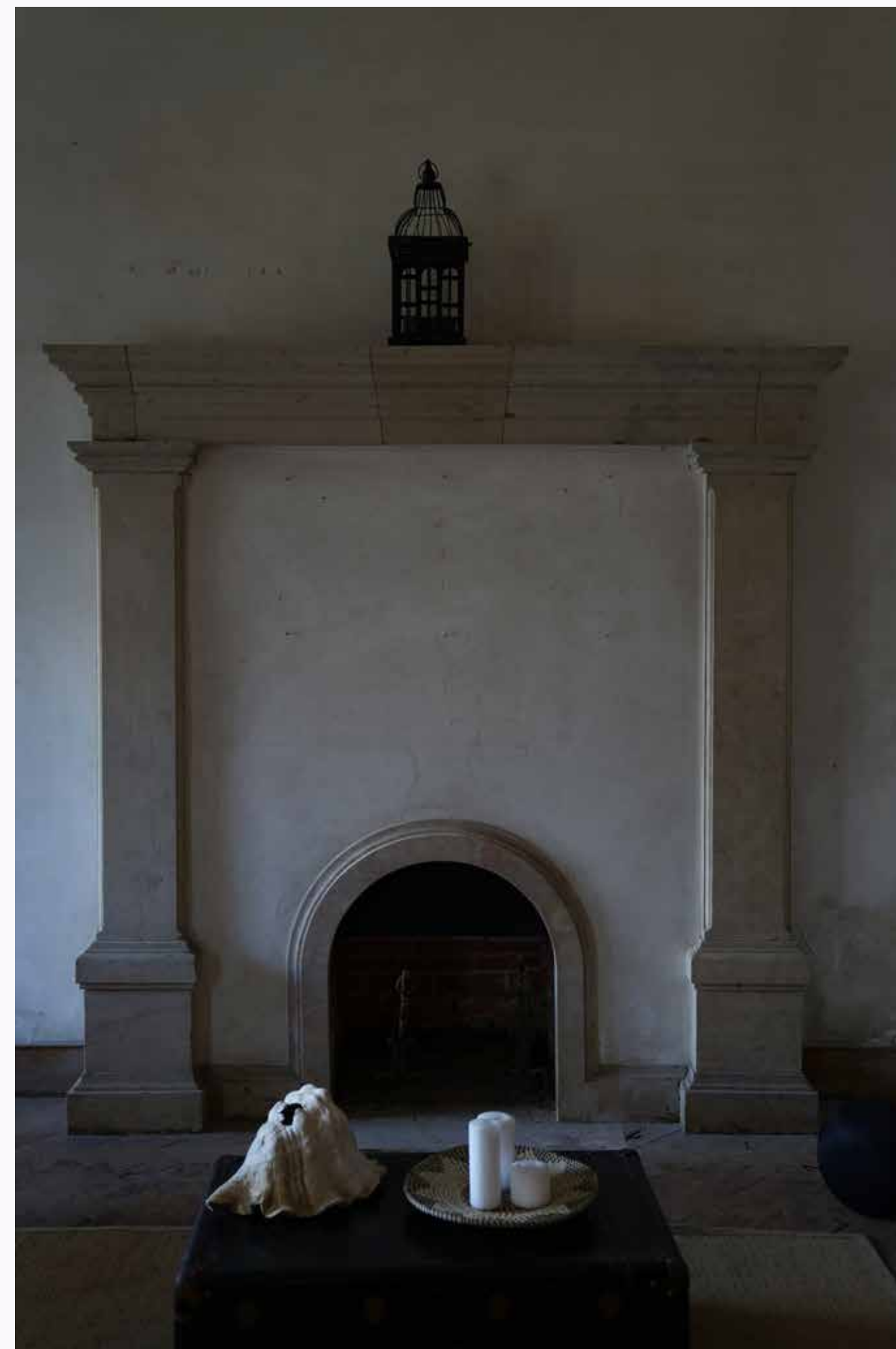
Lareira com emolduramento em cantaria de estilo neoclássico adossado na parede de estuque, situada na Sala da Música.
