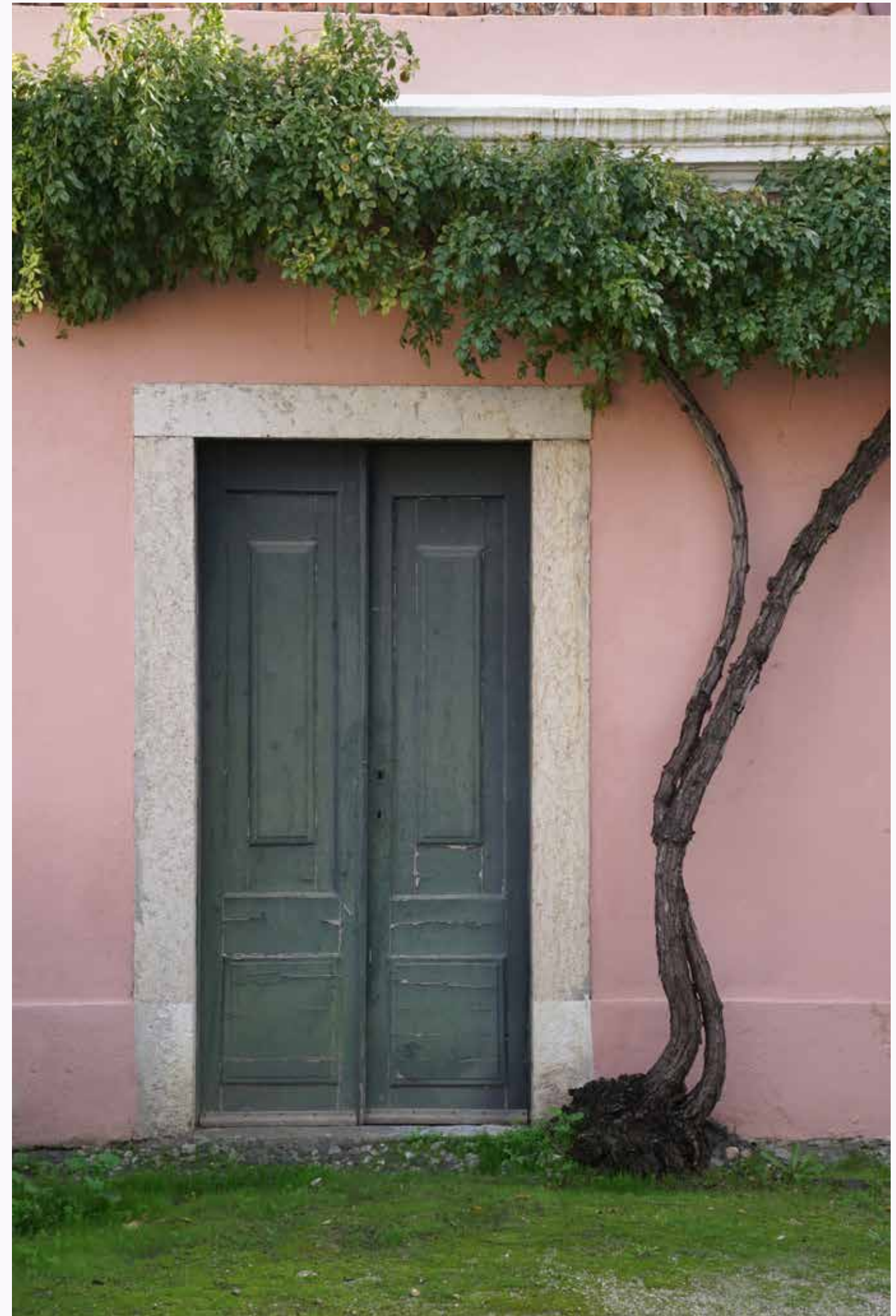
Fachada sul do piso térreo com emblemática porta dupla em madeira pintada com remate em cantaria e encimada por cornija saliente.
