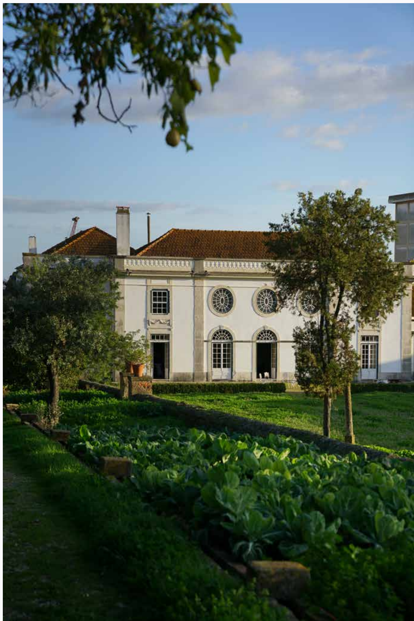
Fachada Norte da Sala dos Óculos com 3 vãos de porta que abrem sobre o jardim, encimados pelos óculos envidraçados e decorados por grinaldas de caixilharia raiada em teia de aranha, uma junção de diferentes elementos dos estilos europeus setecentistas.
